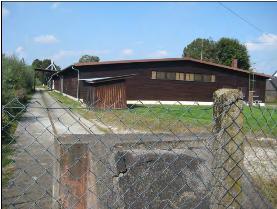
Abb. 1 Bestand alte Getreidehalle mit Abstellgleis
